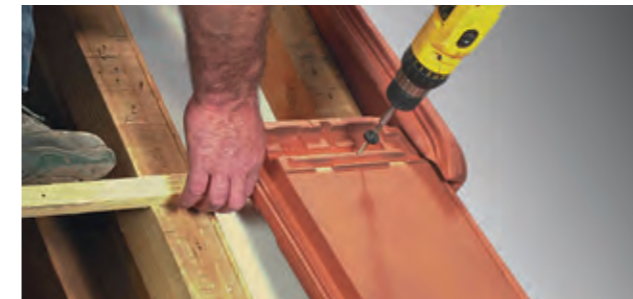
Fixation des tuiles en rives latérales gauche et droite par vis et rondelle d'étanchéité.
