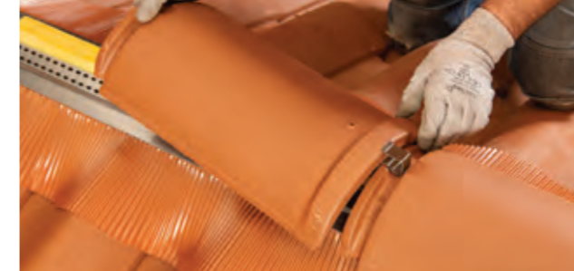
Après mise en place du closoir ventilé, les faîtières sont fixées par crochet adapté au modèle, vissé dans la lisse de rehausse.
