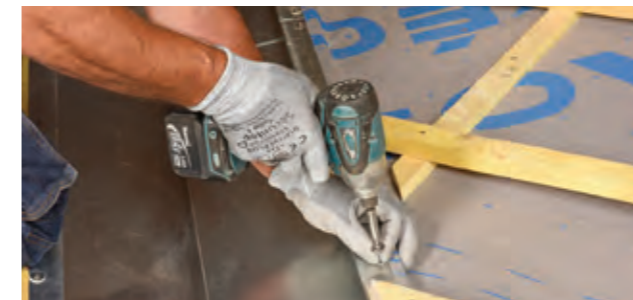
Mise en place de la noue NOOK d'EDILIANS par fixation dans les trous oblongs prévus à cet effet sur les liteaux filants.
