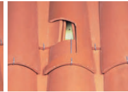
Fixation des tuiles de couvert en plain carré par crochets «S» à raison, sur 10 crochets : 8 crochets «S»
