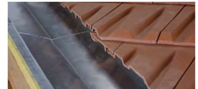
Les tuiles sont tranchées biaisées parallèlement à l'axe de la noue.
