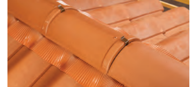
Faîtage réalisé à sec avec faîtières 1/2 rondes à emboîtement grand modèle et closoir ventilé, sans emploi de mortier.
