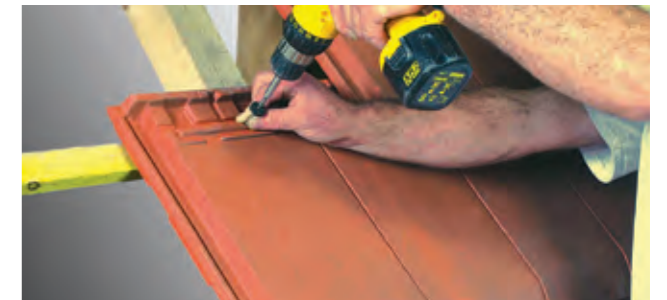
Fixation des tuiles en plain carré pour tenue à forte pente, par vis et rondelle d'étanchéité.
