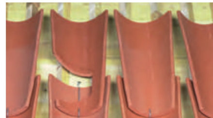
Fixation des tuiles de courant en plain carré par crochets « S » à raison, sur 10 crochets 8 crochets « S »
