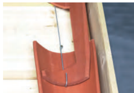
Fixation des tuiles de courant à tenons en rives latérales gauche et droite par crochets Réf. CRCAN.550. La fixation par référence au tableau n°5 art. 3.333 et n° 6 art. 3.334 DTU 40.22 est assurée par les tenons des tuiles et par les crochets.
