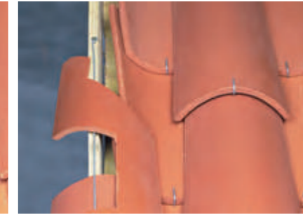
Fixation des tuiles en rives latérales gauche et droite par crochets longs à œil à raison de : 1 crochet long à œil Réf. CRCAN.550 sur 2 tuiles.
