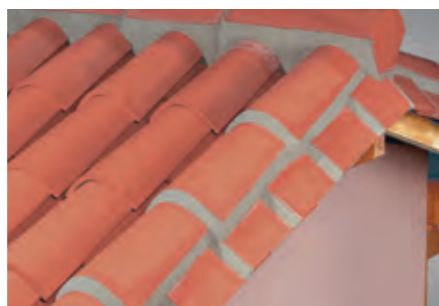
Fixation des bardelis droit 20x30, scellés au mortier correspondant aux prescriptions du DTU.40.22 amendement A2 art. 2.4. Cette mise en œuvre peut s'effectuer sur support continu ou sur liteaux mais nécessite l'établissement d'un support continu au droit des rives.
