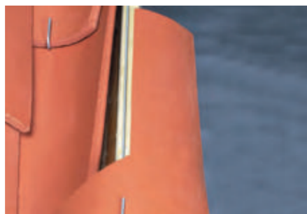
Fixation des tuiles de couvert du 1 er rang d'égout en rive latérale gauche et droite par crochets longs à œil - Réf. CRCAN.550.
