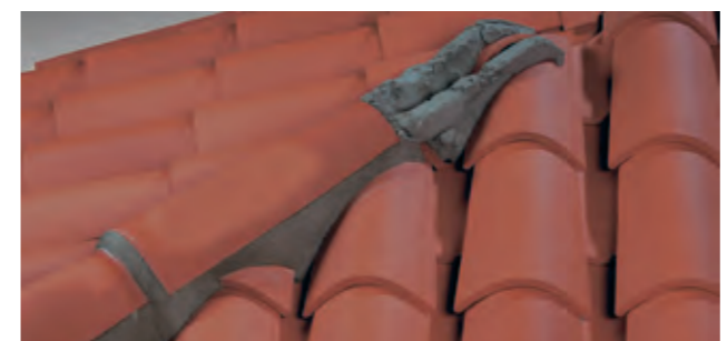
Après coupe des tuiles d'approche, mise en œuvre des tuiles CANAL, utilisation de mortier (D.T.U. 40.22 art. 2.4).
