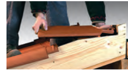
La longueur du versant déterminera l'emploi de la tuile sous-faîtière (1 ou 3/4 ou 1/2 pureau). Détail de pose «à la lyonnaise» avec découpe du bandeau de rive.
