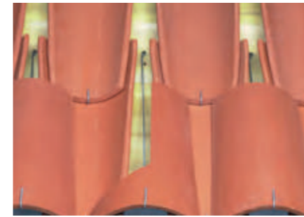
Fixation des tuiles de couvert du 1er rang d'égout, par crochets longs à œil Réf. CRCAN.550
