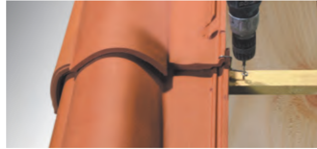
Fixation des tuiles en rive latérale gauche par crochet "V2" réf. CRV02 ou par crochet Harpon.
