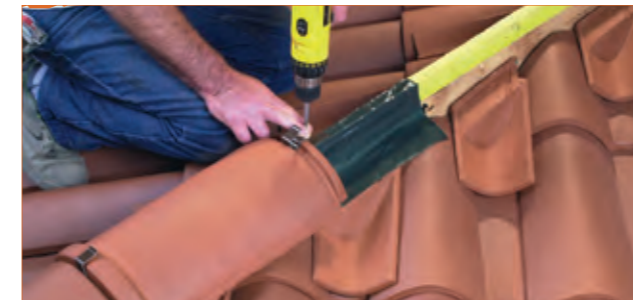
Fixation des arêtiers par crochet adapté au modèle.
