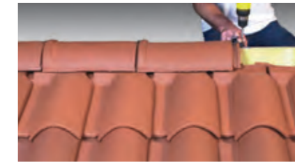
Fixation des faîtières par crochet adapté au modèle, vissé dans la lisse de rehausse.
