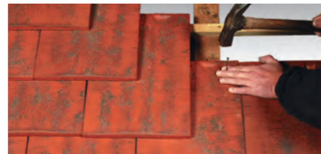
Fixation des tuiles en plain carré, par clou lorsque la zone, le site ou la pente le réclame.
