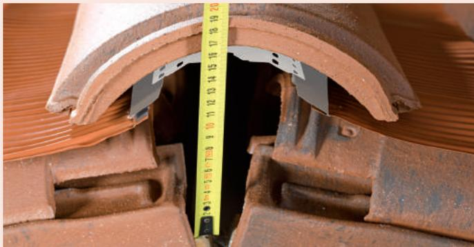
1 - Prendre les mesures du complexe closoir-faîtière et déterminer les hauteurs de la lisse de rehausse et du bois de fourrure pour qu'a posteriori la faîtière ne repose pas sur le closoir.
