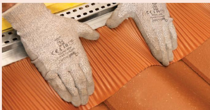
4 - Maroufler les bavettes du closoir sur les tuiles. Positionner et fixer les faîtières de manière à ce que le recouvrement soit opposé aux vents dominants. Appliquer de l'huile de patine sur les bavettes plomb, en particulier naturel, pour optimiser la résistance à la corrosion. Recouvrir le closoir rigide Shark+ avec les tuiles faîtières ou les arêtiers, compatibles avec les petits éléments de couverture utilisés en plain carré.
